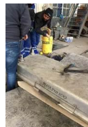
Verbinden mit einer Airbag-Presse
