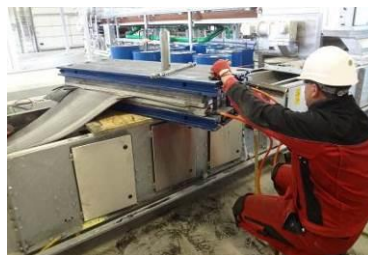
Heißvulkanisieren mit einer Waterbag-Presse
