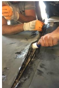
Delamination der Verbindung
