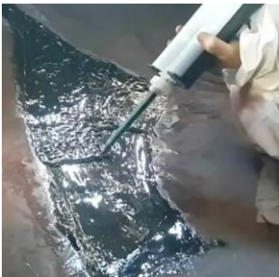
Delamination der Decke in der Verbindung
