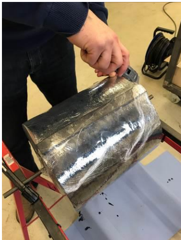
Stretch-Folie entfernen nach Aushärtung
