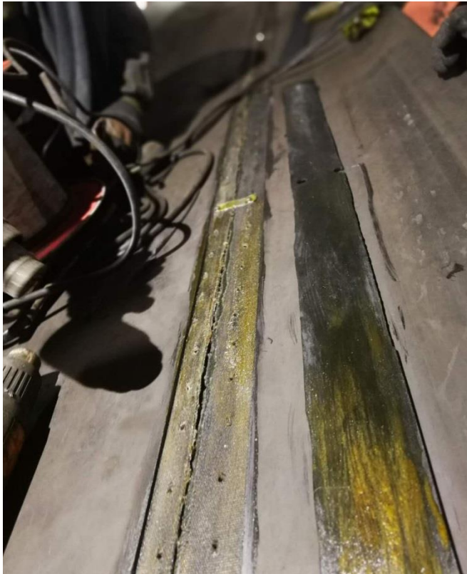
Vorbereitung der Kontaktfläche und des Gummistreifens
