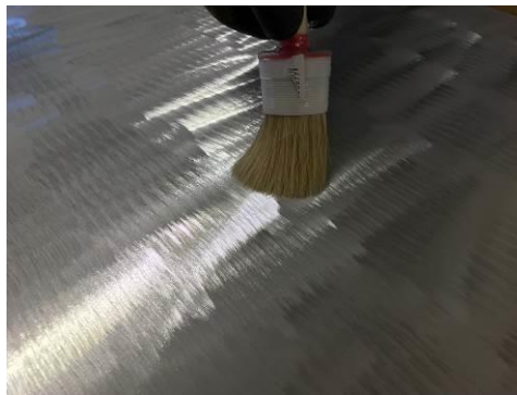
Reinigen der Oberfläche mit einer einfachen Bürste
