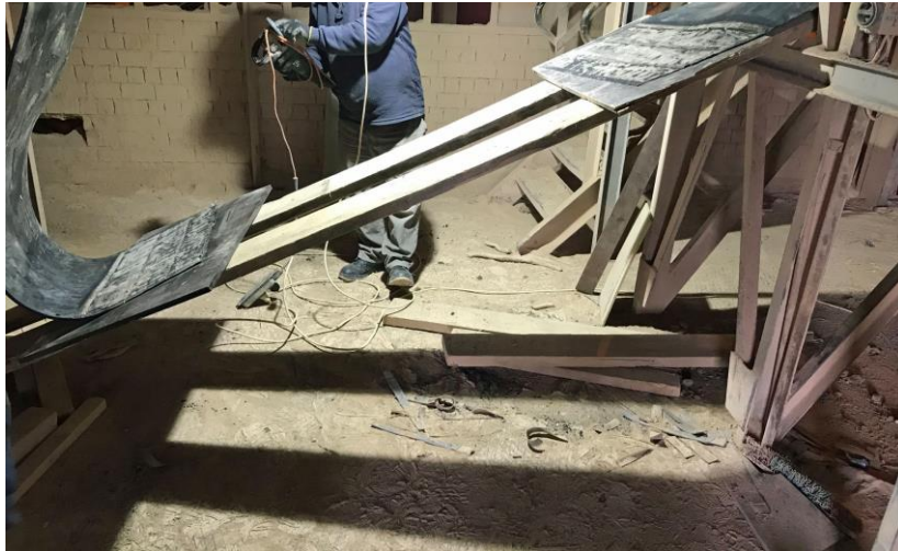
Vorbereitung der Stufenverbindung im Untertrum
