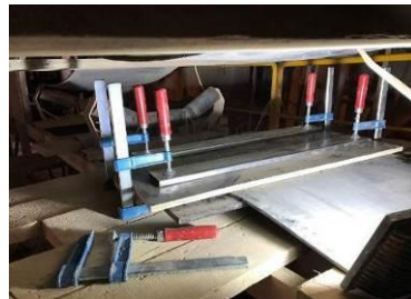
Vulkanisieren bei +10°C mit einer Fixiervorrichtung
