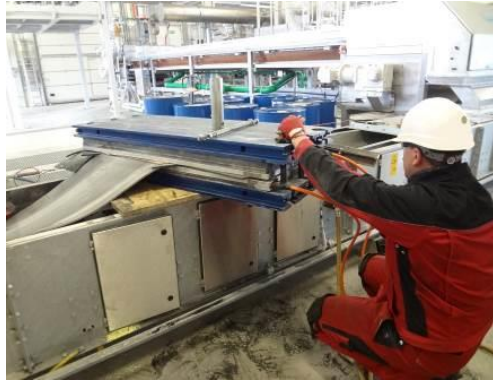
Vulkanisieren mit einer Waterbag-Press
