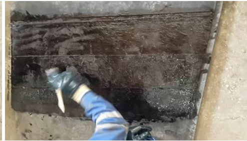
Verteilen und Einreiben in die Poren mit einer Bürste
