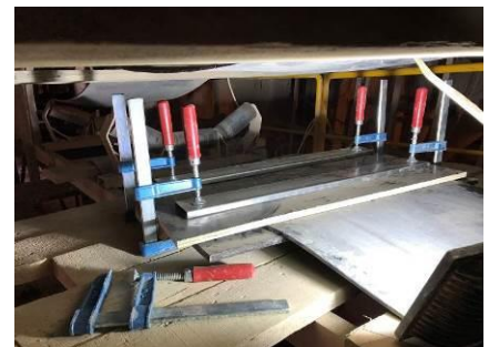
Stufenverbindung von mehrlagigen Bändern mit einer Fixiervorrichtung
