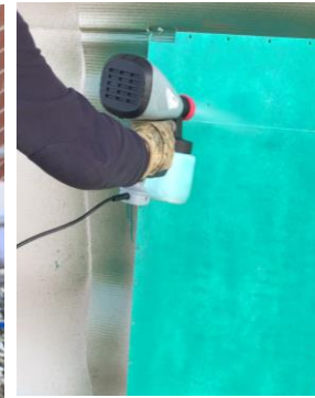
Auftragen mit einer pneumatischen Sprühpistole oder Airless-Sprühpistole
