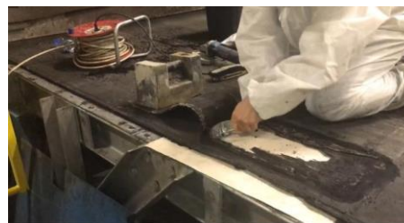
Anrauen der abgeschliffene Obeefläche
