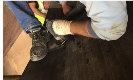
Anrauen der beschädigten Oberfläche
