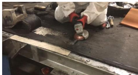
Abschleifen der beschädigten Oberfläche
