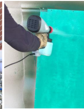
Auftragen mit einer pneumatischen Sprühpistole oder Airless-Sprühpistole
