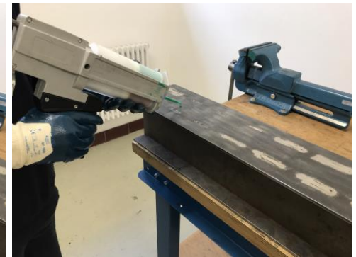
Auftragen mit einer Pistole und mit einem Pinsel oder einem Spachtel verteilen
