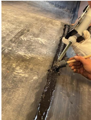
Material mit einem Pinsel einarbeiten und sofort auffüllen
