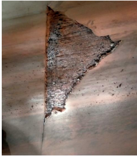
Delaminierte Stelle der oberen Deckplatte
