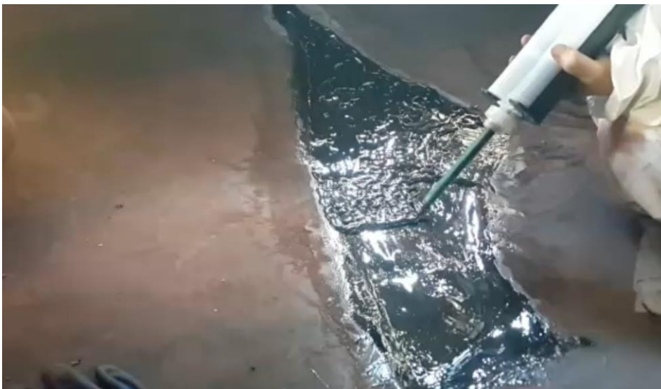
Oberflächenschaden mit Multiface 1.5 Thixotropisch auffüllen
