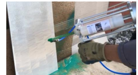
Antikorrosion-Sprühbeschichtung
