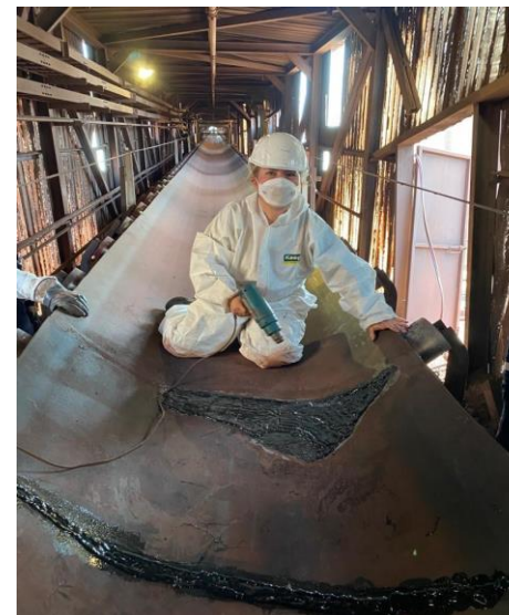
Beschleunigte Aushärtung mit einer Heizpistole
